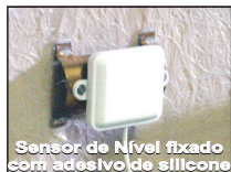
Sensor de Nível fixado na tubulação da sucção
