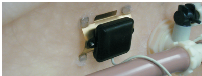
Sensor de Nível fixado no casco da banheira pelo lado externo
